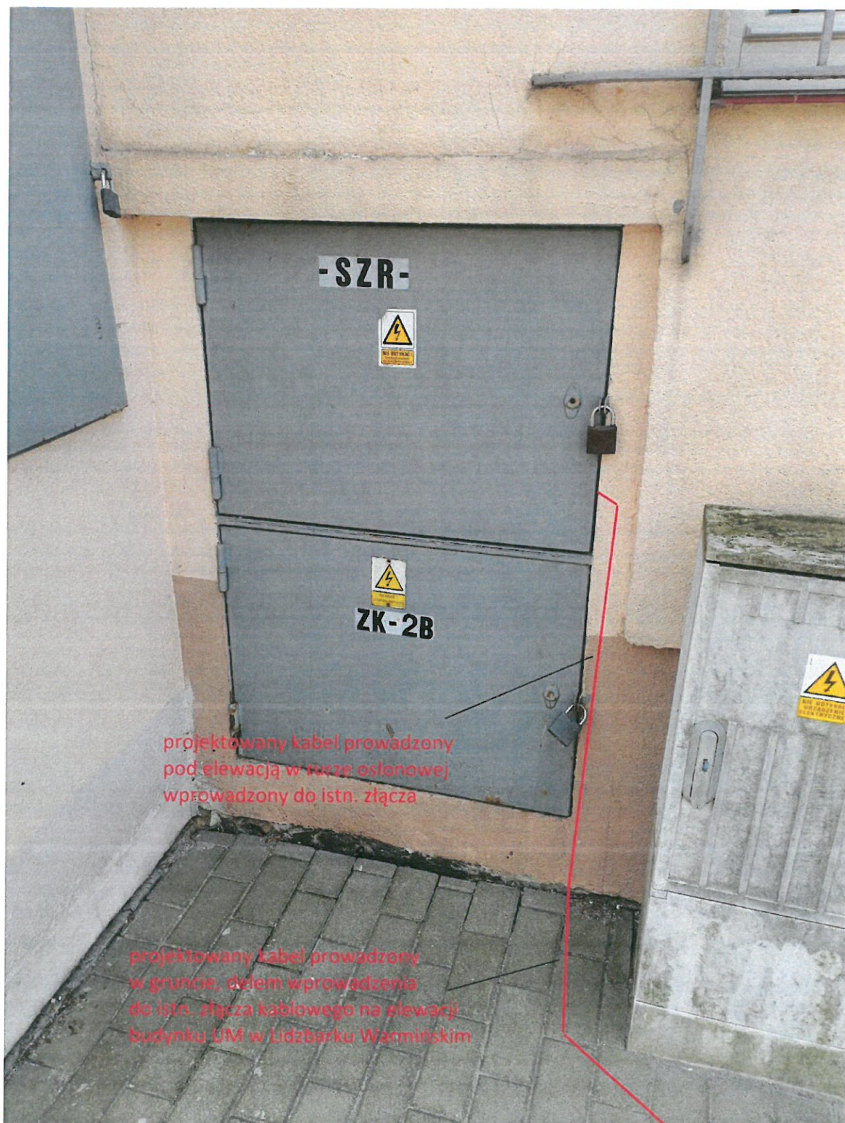
Trasa prowadzenia kabla zasilającego z agregatu do istniejącego złącza kablowego pod elewacją budynku UM w Lidzbarku Warmińskim przy ul. Świętochowskiego 14.
